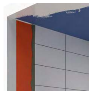
BILD N – Tak målat efter platsättning
